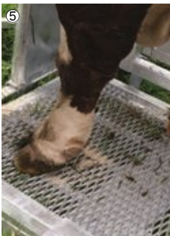
Optimale antislip door stekmetalen rooster
