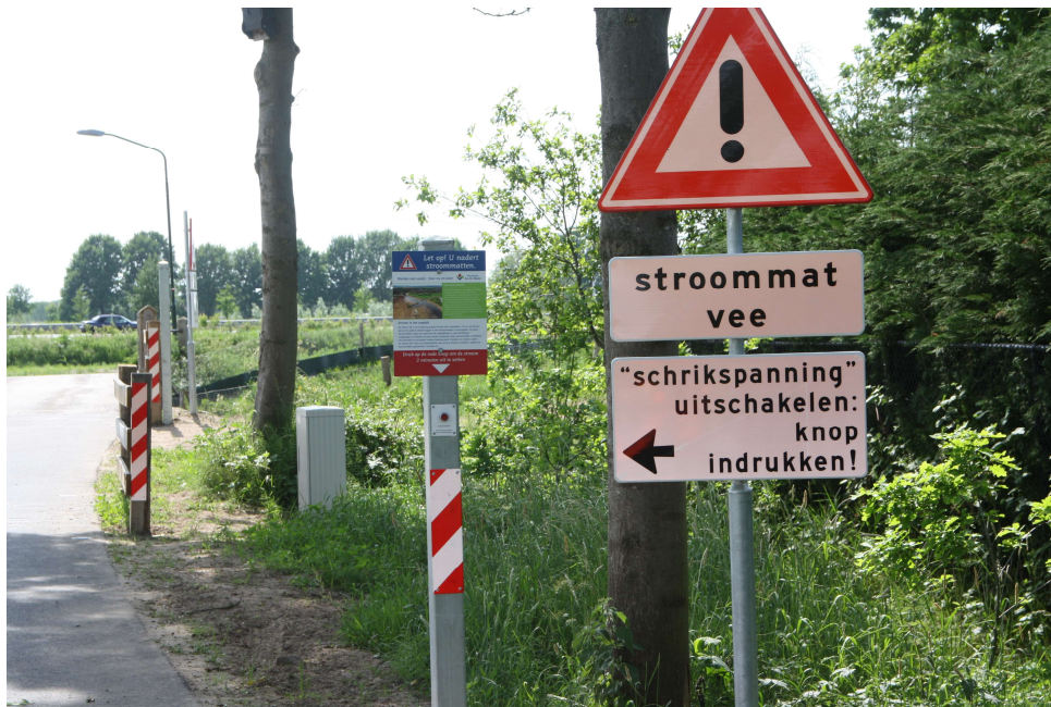
Voorbeeld paal met drukknop. Achterzijde veldkast met apparatuur.
